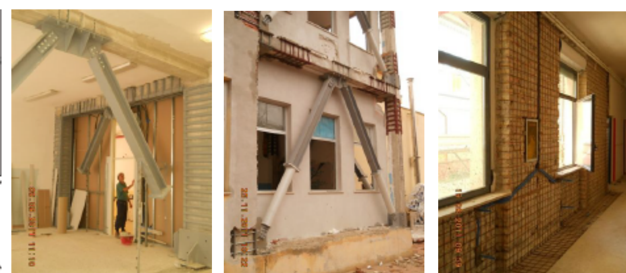
Interventi di miglioramento e/o adeguamento sismico di tre edifici scolastici del Comune di Pescara a seguito di analisi di vulnerabilità sismica che hanno determinato valori fuori norma dell'Indice di Rischio. (foto dell'autore)
