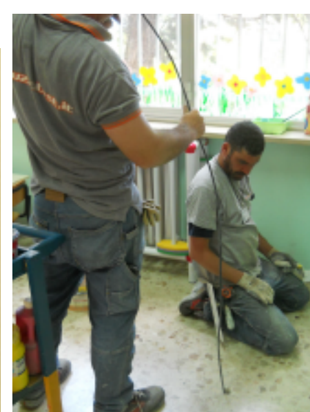
Sonreb, martinetti piatti e endoscopia del solaio per l'analisi di vulnerabilità delle scuole elementari di Pescara. (foto dell'autore)
