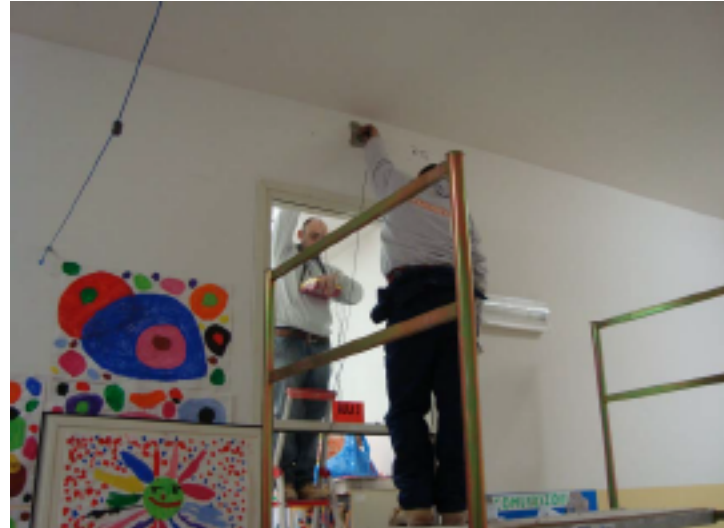
Estrazione di carota abbinata alla verifica della resistenza in una trave in c.a. di un vano scala in una palestra scolastica di Pescara. (foto dell'autore)
