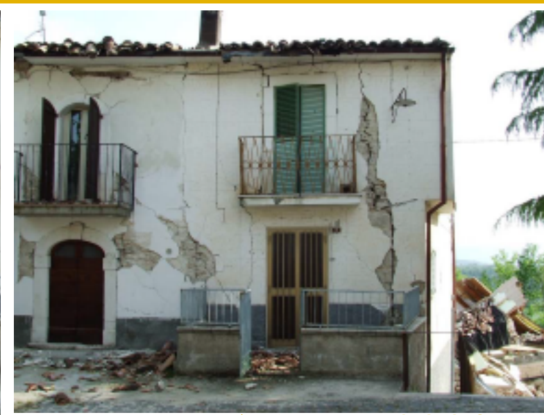
Castelnuovo di San Pio delle Camere (Aq). Danni causati dal sisma del 6 Aprile 2009 (foto dell'autore)
