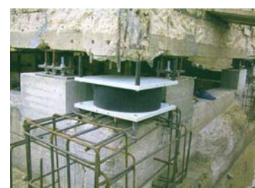
Figure 20-21-22. Montaggio degli isolatori elastomerici. In un locale seminterrato - In un edificio di nuova costruzione - In un edificio esistente. (Foto archivio FIP Industriale spa)
