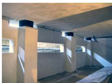
Figure 20-21-22. Montaggio degli isolatori elastomerici. In un locale seminterrato - In un edificio di nuova costruzione - In un edificio esistente. (Foto archivio FIP Industriale spa)
