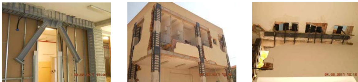
Figure 4-5-6. Rinforzi dei telai in calcestruzzo armato con carpenteria metallica eseguite per l'adeguamento sismico di due edifici scolastici del Comune di Pescara. (Foto dell'autore)
