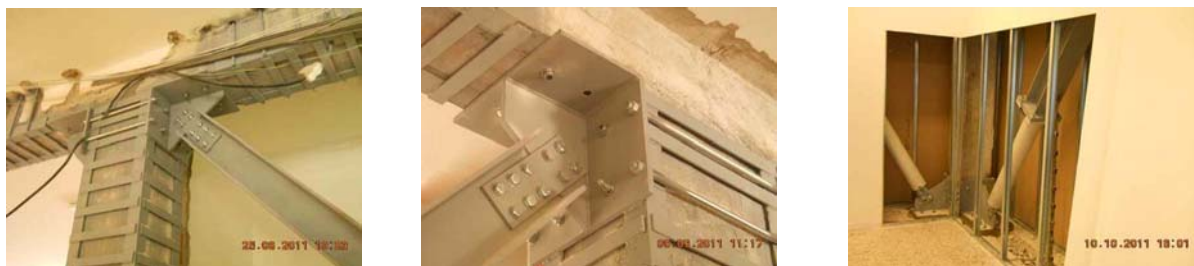
Figure 14-15-16. Montaggio dei controventi dissipativi in interno per l'adeguamento sismico di un edificio scolastico del Comune di Pescara. (Foto dell'autore)
