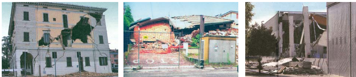
Figure 1-2-3. Danni causati dal sisma del Maggio 2012 in Emilia Romagna. Municipio - Opificio artigianale - Stabilimento industriale. (Foto archivio SPI CGIL)
