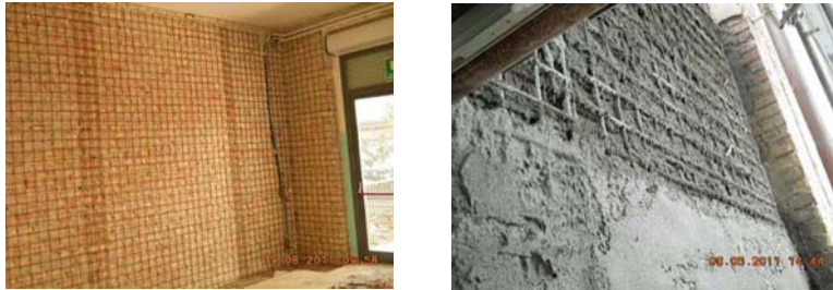
Figure 9-10. Realizzazione di intonaco armato sulla muratura esistente per l'adeguamento sismico di un edificio scolastico del Comune di Pescara. (Foto dell'autore)
