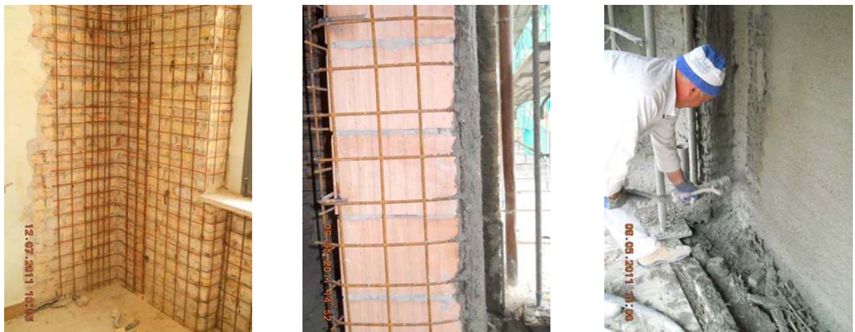
Figure 11-12-13. Particolare della sovrapposizione della rete e dell'applicazione della malta fibrorinforzata per la realizzazione di intonaco armato per l'adeguamento sismico di un edificio scolastico del Comune di Pescara. (Foto dell'autore)
