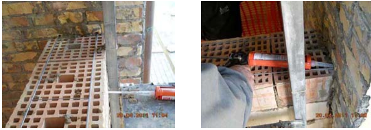
Figure 7-8. Realizzazione di nuova muratura con blocchi sismici in laterizio ammorsate a quella esistente per l'adeguamento sismico di un edificio scolastico del Comune di Pescara. (Foto dell'autore)
