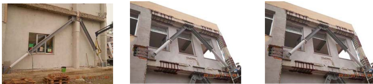
Figure 17-18-19. Montaggio dei controventi dissipativi in esterno per l'adeguamento sismico di un edificio scolastico del Comune di Pescara. (Foto dell'autore)
