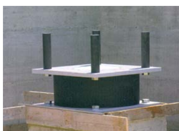
Figure 20-21-22. Montaggio degli isolatori elastomerici. In un locale seminterrato - In un edificio di nuova costruzione - In un edificio esistente. (Foto archivio FIP Industriale spa)
